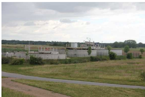
Photo 41 : station d'épuration de Saint-Benoît
