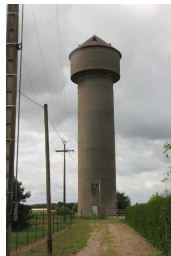
Photo 40 : château d'eau de Saint-Benoît
