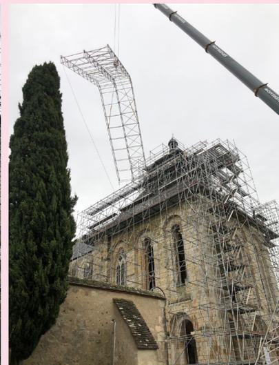
La partie supérieure de la toiture de la tour (dôme à l'impériale et lanternon) a été déposée au sol afin de gagner du temps et de faciliter le travail des ouvriers.
